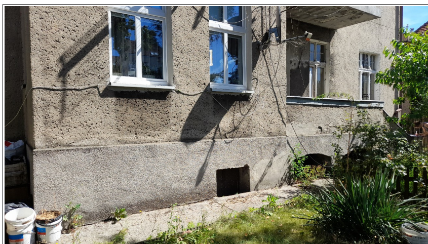
OKNO PIWNICZNE, OBUDOWA OKNA, OPASKA PRZY BUDYNKU – ZŁY STAN TECHNICZNY
